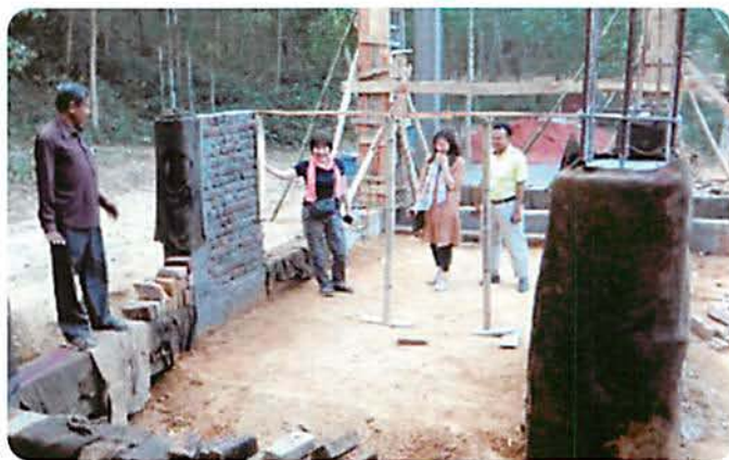
コミッタの小学校建設現場（2014年3月）
