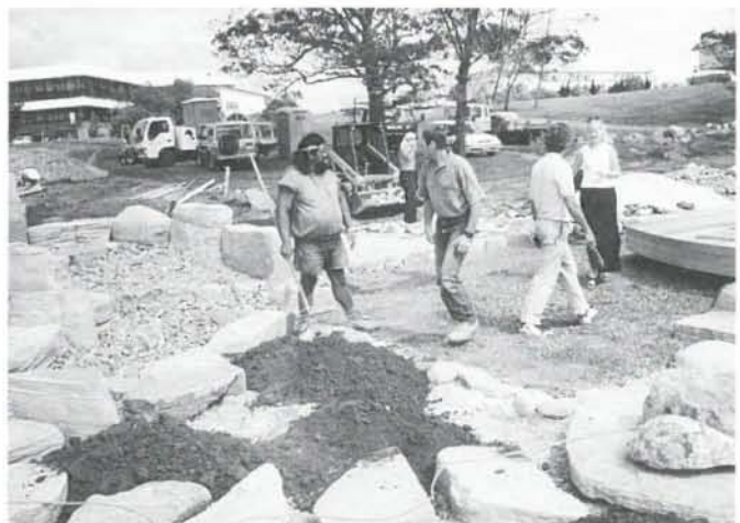
△ 庭園建設現場風景 △
